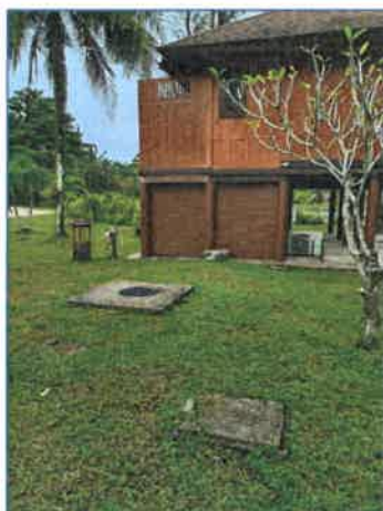
ภาพถ่ายที่ 2.2-8 ระบบบำบัดน้ำเสียเบื้องต้นและถังตกไขมัน
